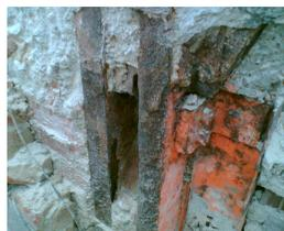
Korrosion am Stahlfachwerk
